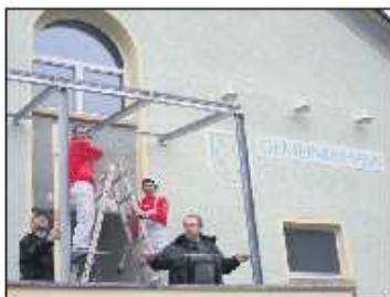
Letzte Außenarbeiten im November
